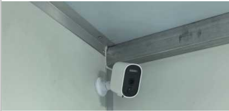
危险废物仓库
