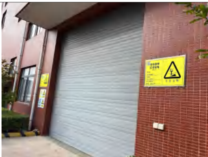
危险废物仓库
