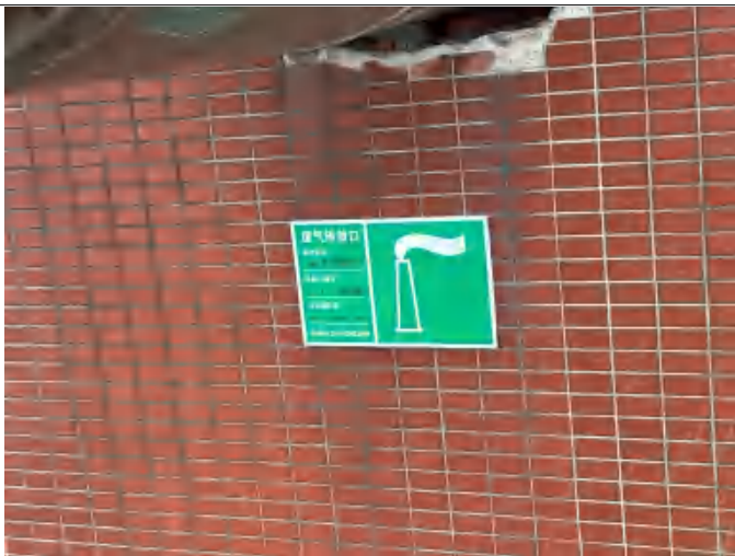
废气排放口环保标识牌 (DA004)
