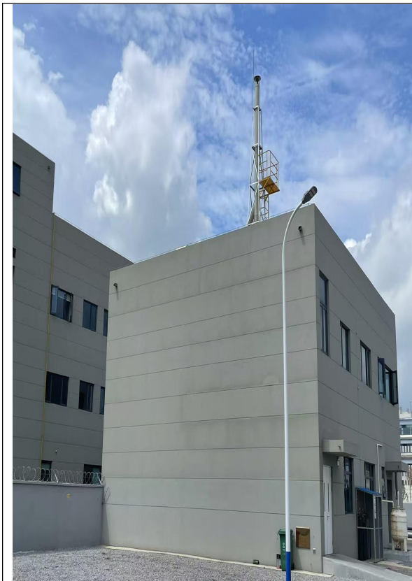
FQ-09 排气筒 15 米 (DA008)
