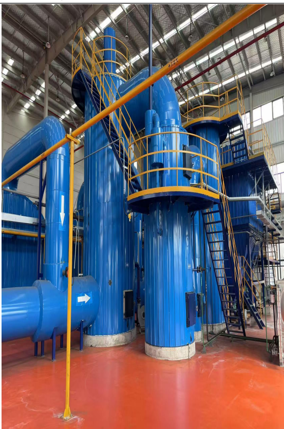
FQ-06 处理设施 (二次炉+余热炉+急冷+干式脱酸+布袋除尘+碱洗)
