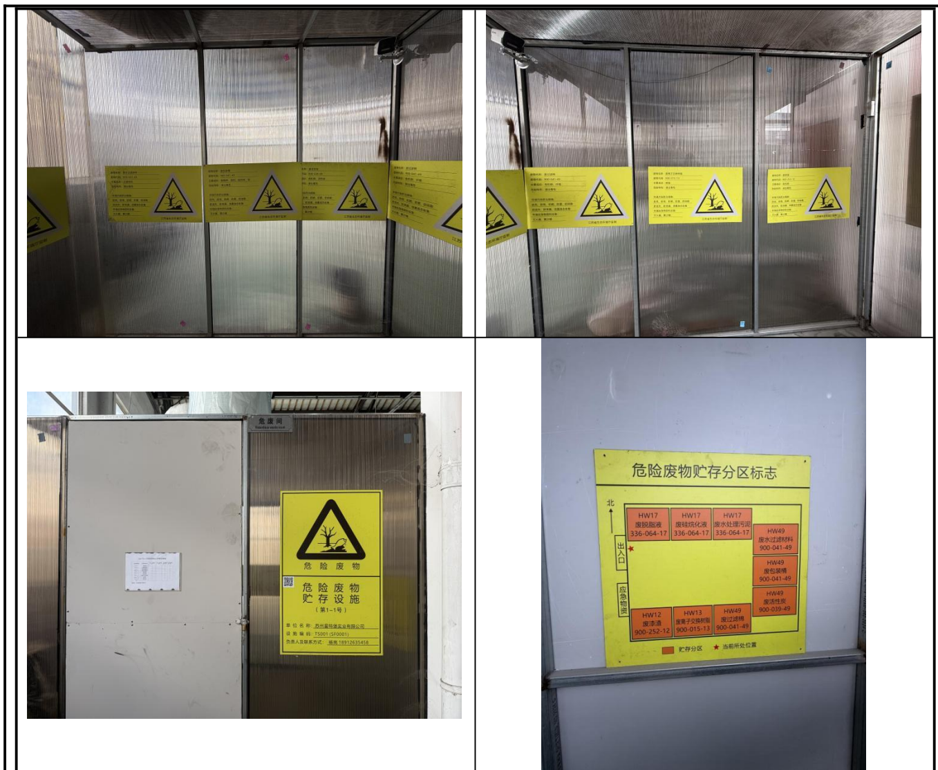
图 3-3 危险废物仓库
