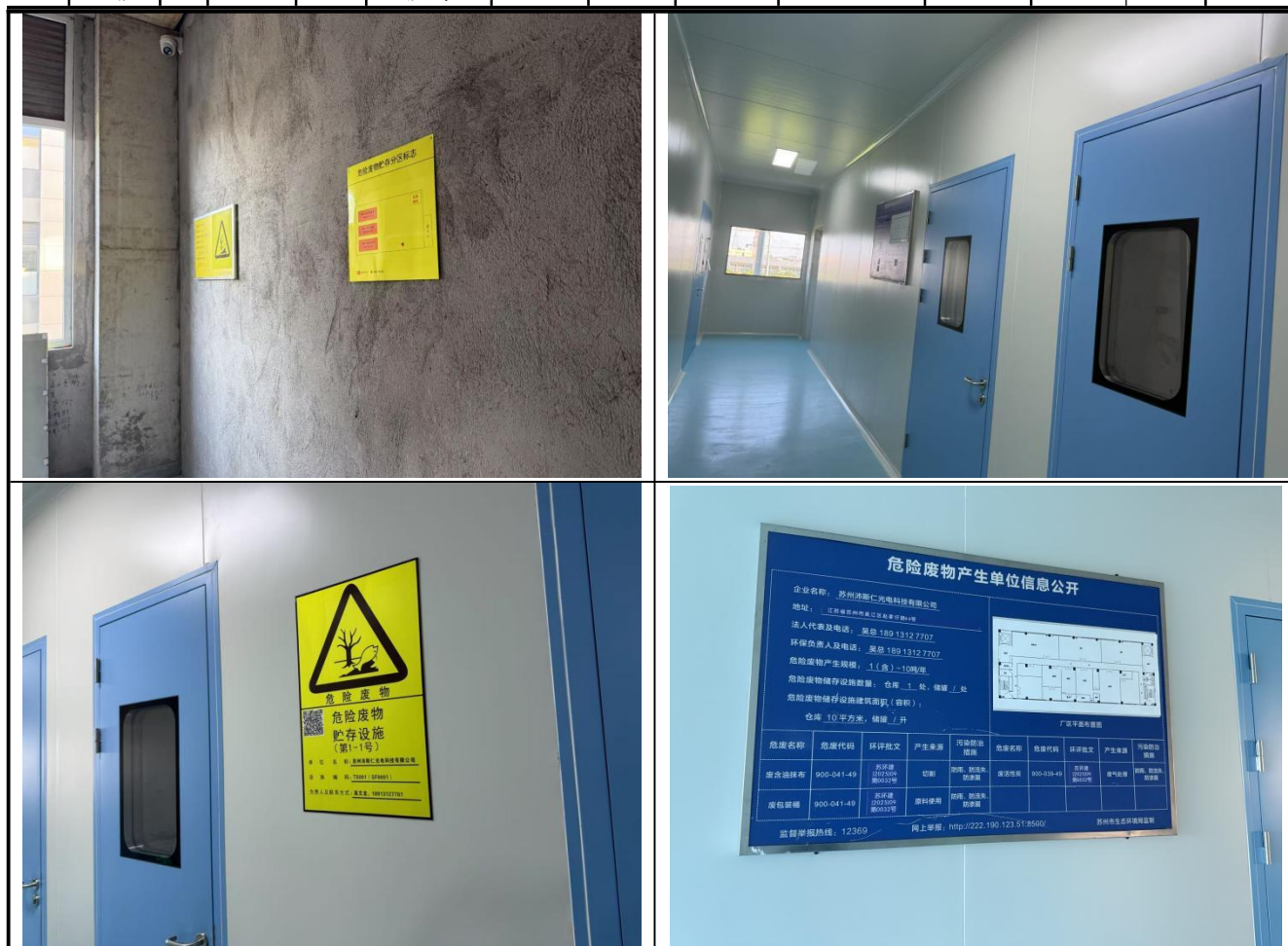
图 3-3 危险废物仓库
