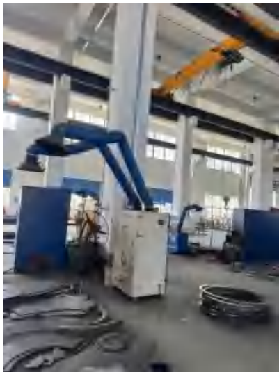
焊接废气经集气罩收集 (移动式烟尘净化器处理后无组织排放)
