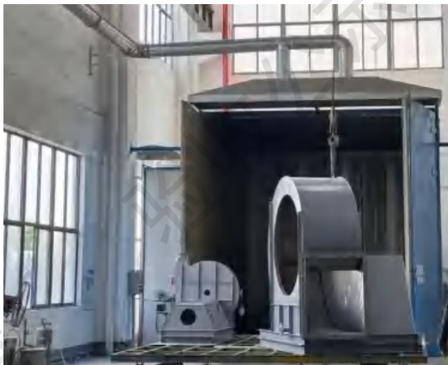
固化、天然气燃烧废气集气罩收集
