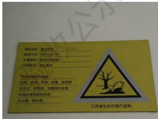
危险废物环保标识牌（废活性炭）
