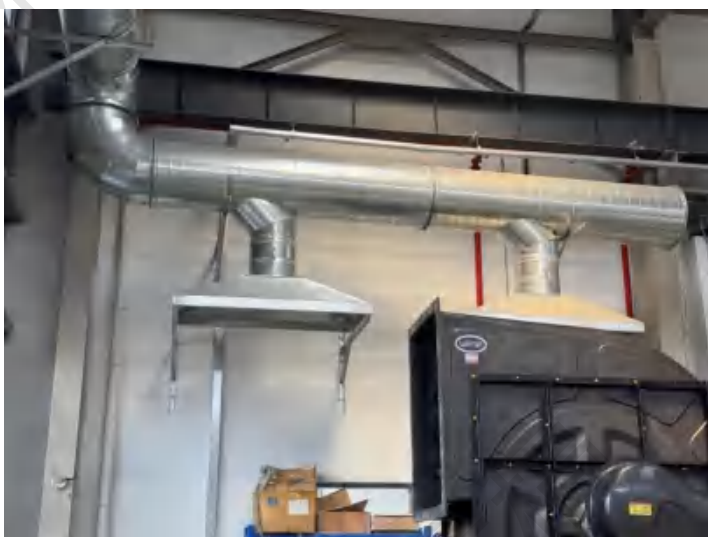
修补、设备清洗废气经集气罩收集
