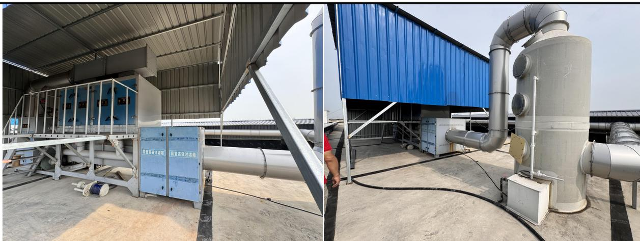
图 3-1 现场废气装置及排气筒照片（三套一致）
