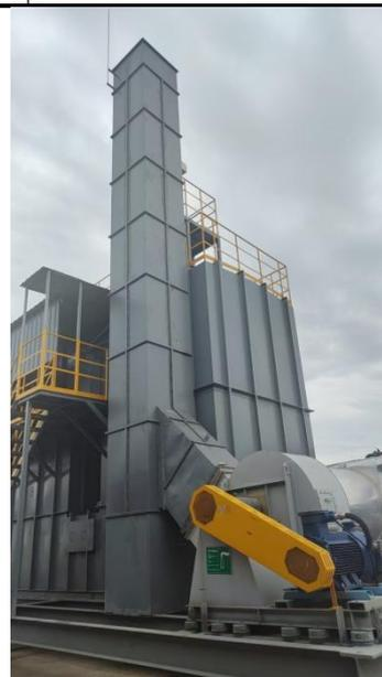
图3-1 2套DMF吸收塔+干式过滤+RTO+DA001排气筒
