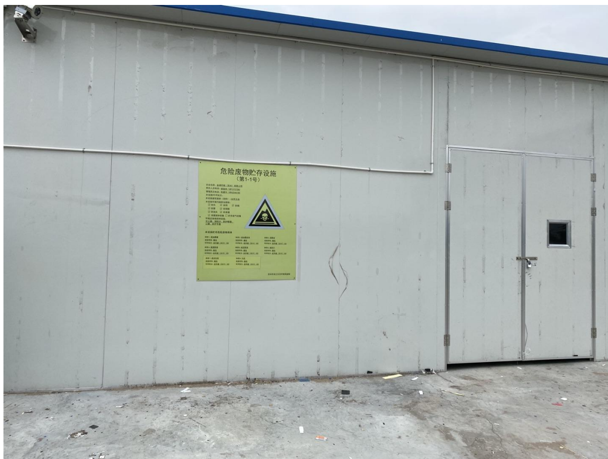
附图 7 危险废物暂存仓库（外部）
