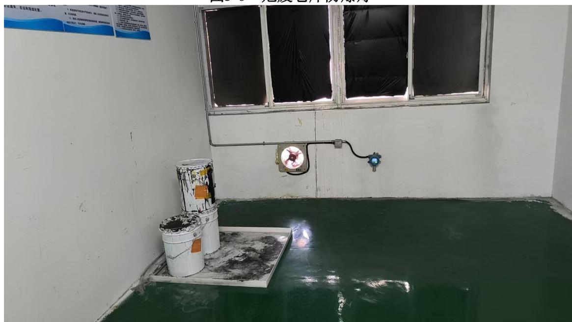
图3-7 危废仓库通风扇、危废“废油墨”及防渗漏托盘
