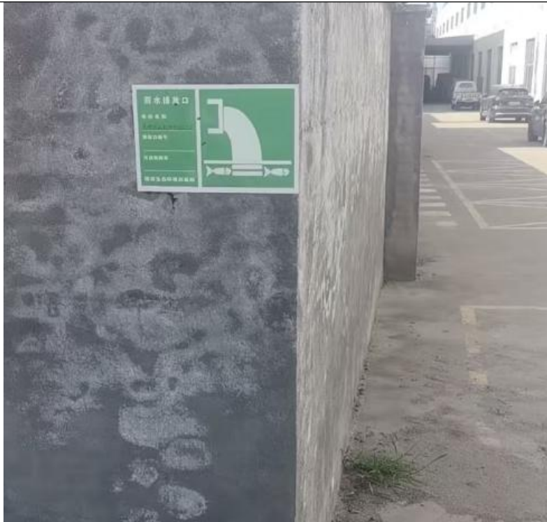
图 3-1 生活污水、雨水排放口
