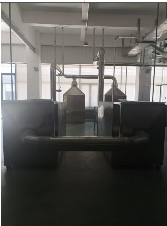
DA034 排气筒图（泡检废气排气筒）
