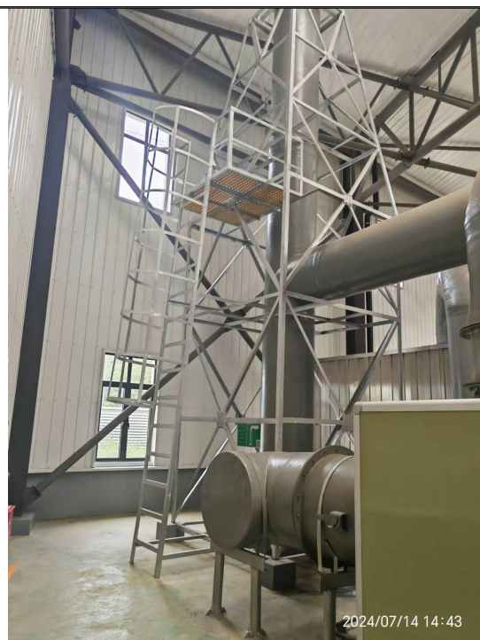
DA034 排气筒图（废水站废气排气筒）
