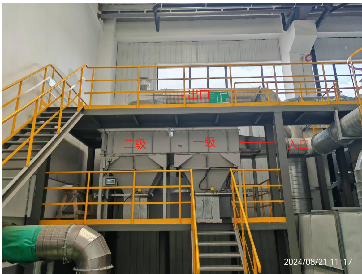
图2-2 变更后二级滤芯除尘示意图
