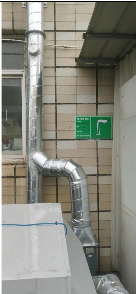
图 3-1 现场排气筒照片
