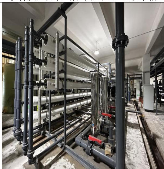
反渗透装置（二级反渗透）
