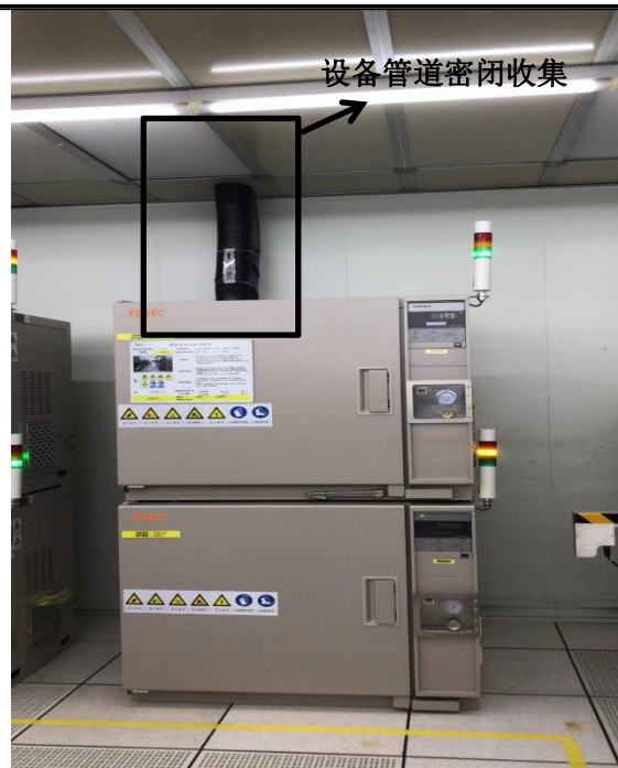
图 3-2 晶圆粘贴后段烘烤废气收集情况
