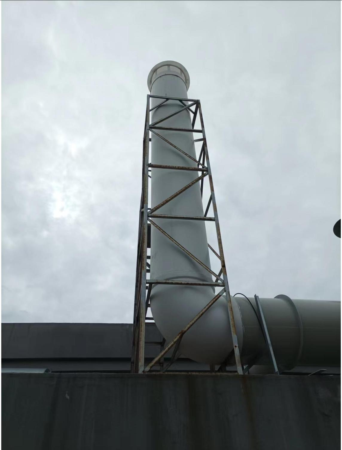
图 3-1 过滤棉+DA001 排气筒
