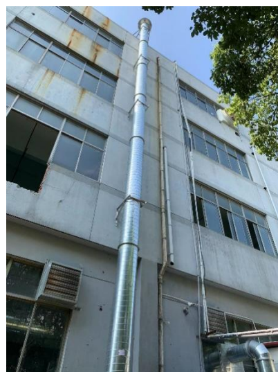
图 3-2 废气排气筒
