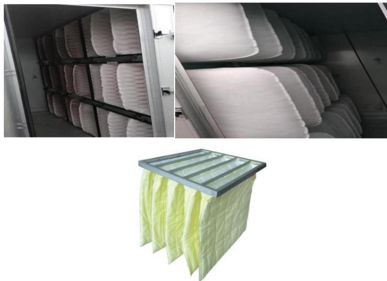
图4-3 过滤系统滤袋细节图
