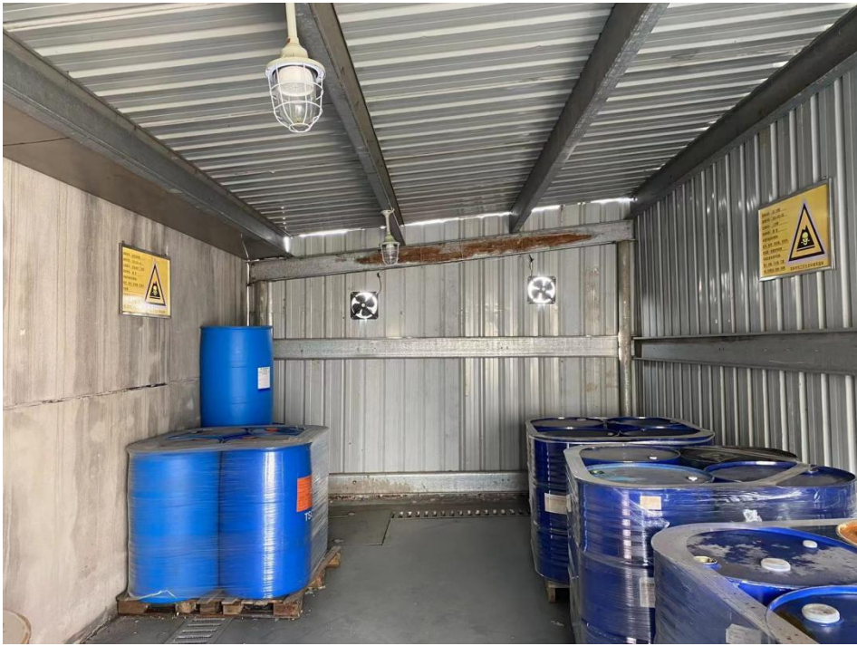
危废仓库内部照片
