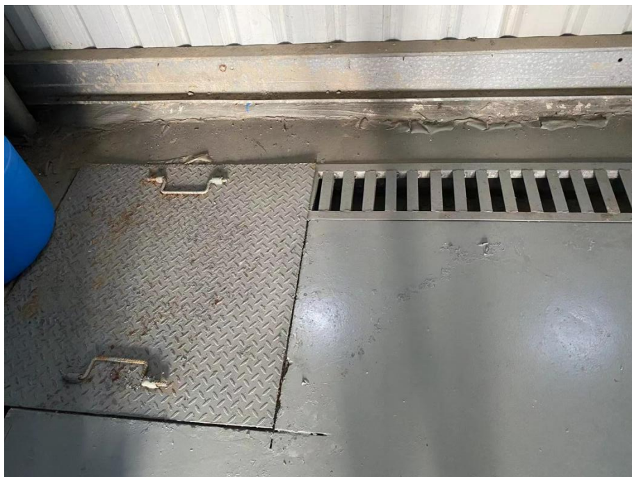
危废仓库内部截留措施照片
