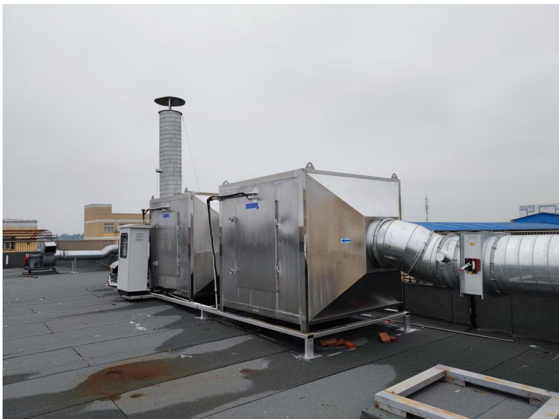
图4-1：本项目废气处理设备及排气筒
