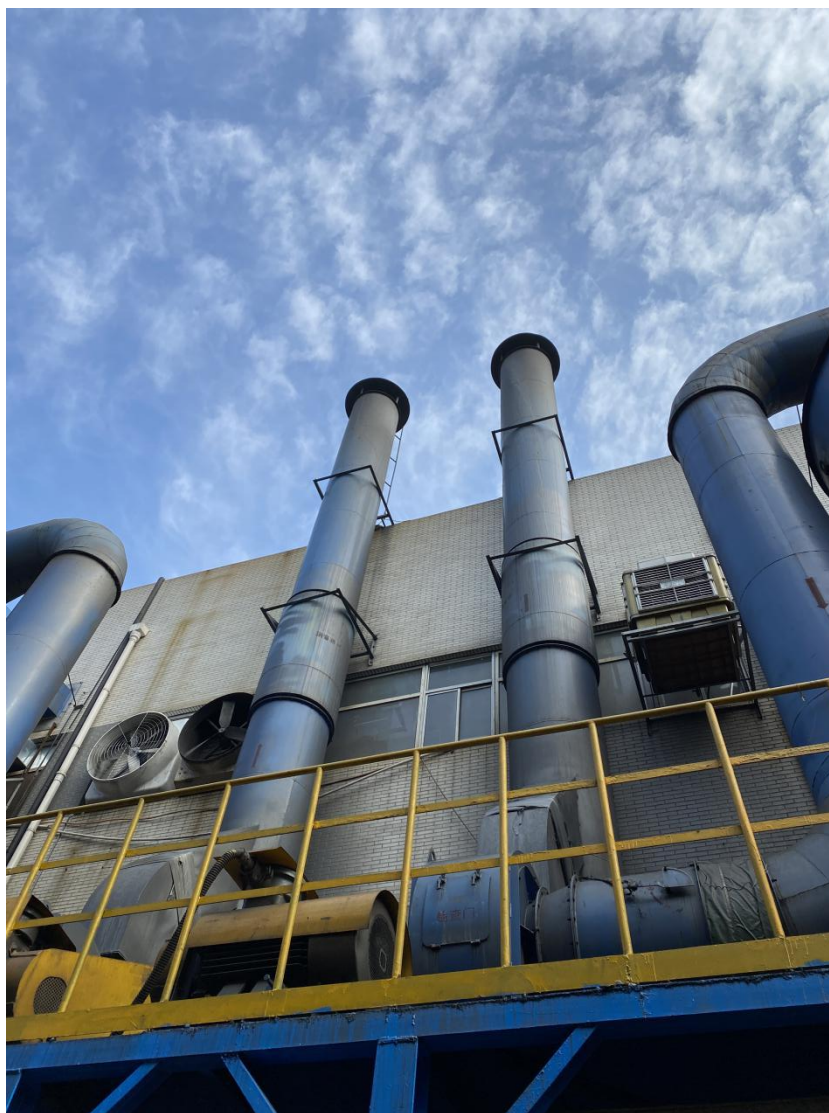
图 4-5 喷砂 5#-6#废气排口
