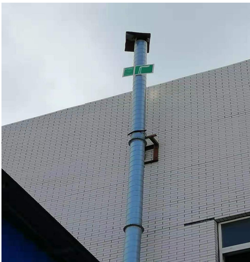
图 4-8 废水浓缩设备 16#废气排口
