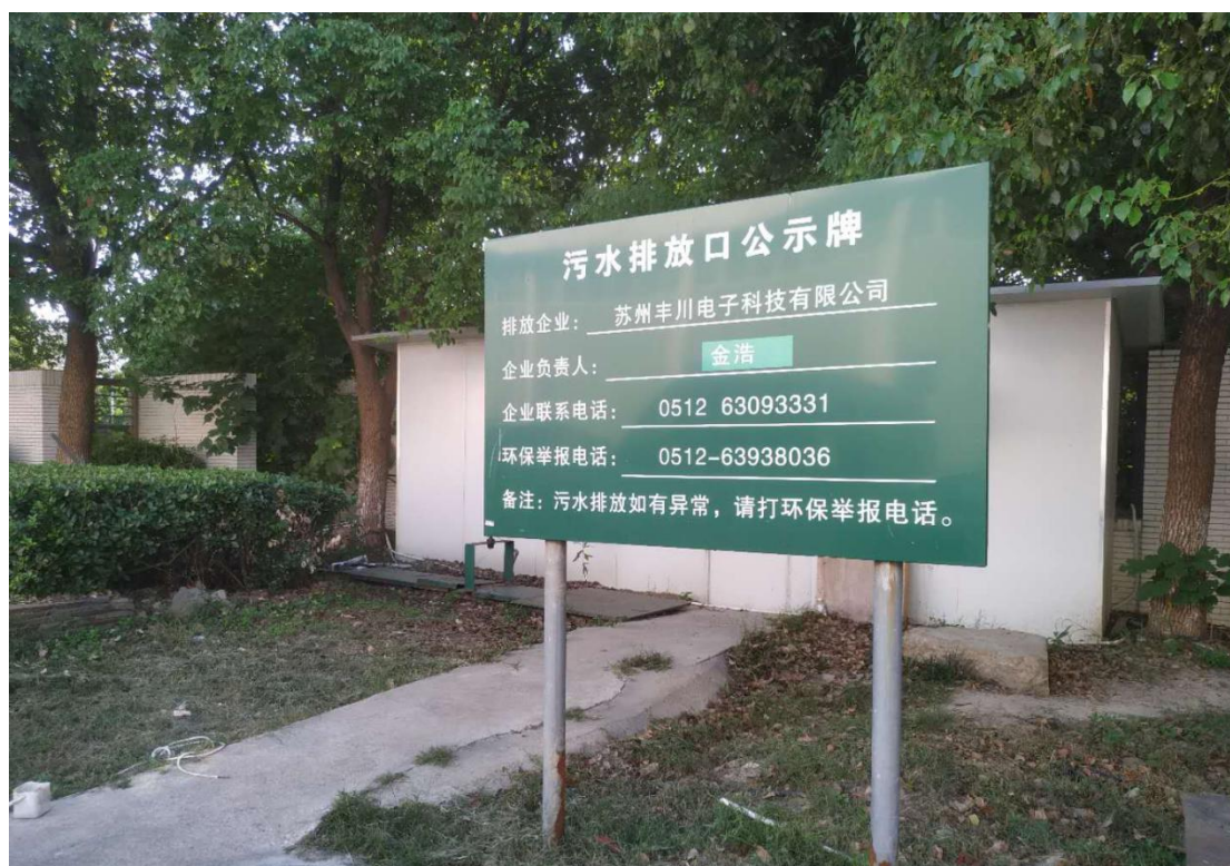
图 4-3 本项目生活污水排口
