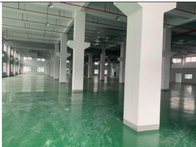
图 3-1 厂区内地面照片
