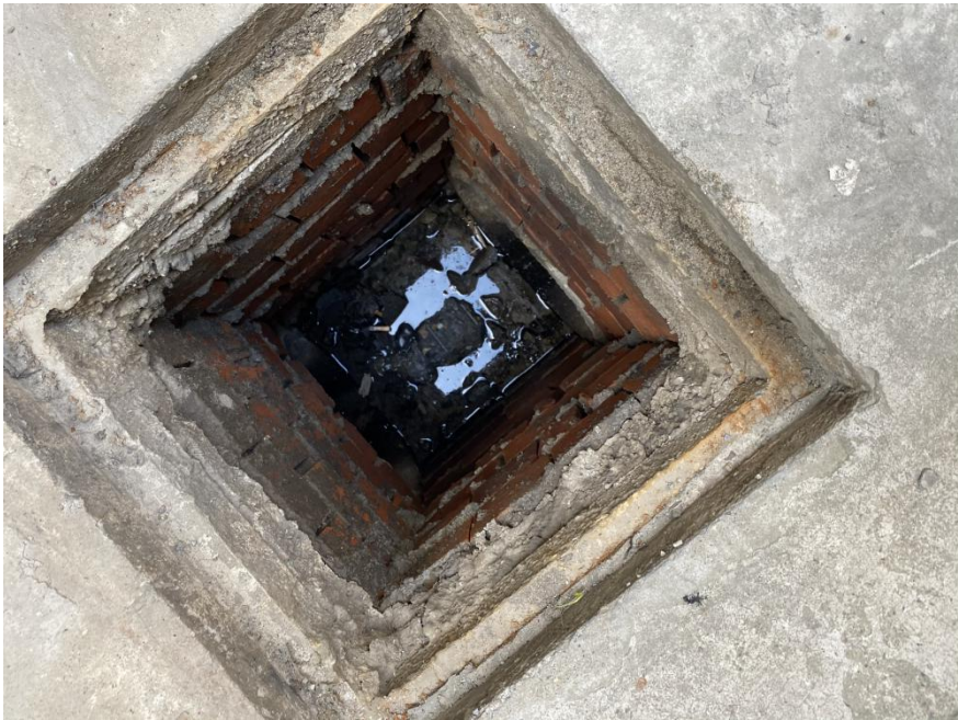
图 4-3 本项目雨水排口
